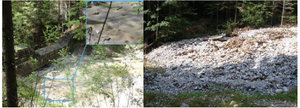
Abb. 7: Geschiebesperre im hinteren Lohmgraben bei hoher Wasserführung des Baches im Frühjahr 2013 (links, Foto: Simic) und nach dem Ereignis vom 9.8.2013 mit Geschiebe bis zum Überlauf gefüllt (rechts, Foto: Fischer); damit die Funktion des Auffangbeckens erhalten bleibt, muss das Material möglichst rasch entfernt werden
