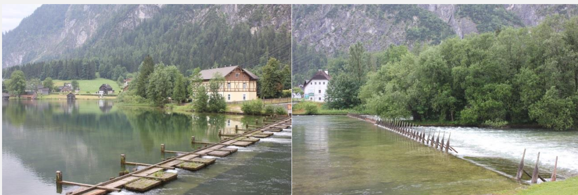
Abb. 26+27: Die Seeklause in Bad Goisern/Steeg: links die eigentliche Klause, rechts die Gegenwehr-Anlage „Polster“ (Fotos: Dormann)
