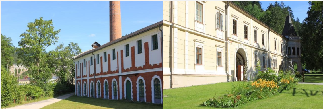
Abb. 18 (links): Industrie-Denkmal altes Töpperwerk; links davon der Lueger-Aquädukt, der größte der II. Wiener Hochquellenleitung, in Neubruck
