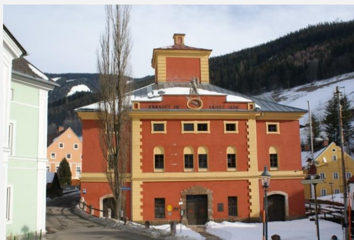
Abb. 2: Radwerk IV in Vordernberg (Foto: Lieb)
