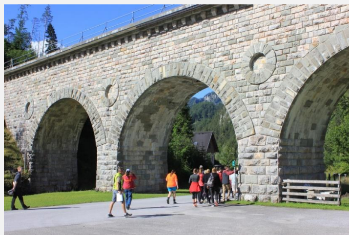
Abb. 12: Aquädukt der II. Wiener Hochquellenleitung in Hopfgarten bei Wildalpen (Foto: Dormann)
