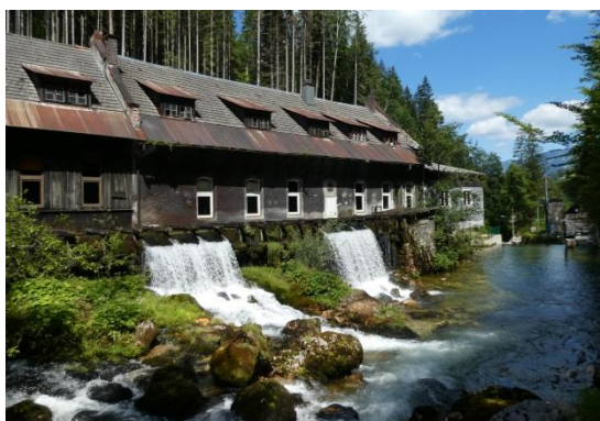
Abb. 45: Der oberste Abschnitt des industriellen Ensembles Rossleithen (Kraftwerk), Blick talaus (Foto: Lieb)
