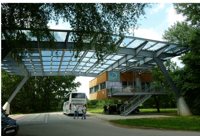
Abb. 4: Hochwasser-geschützte Zollstation von Angern an der March
