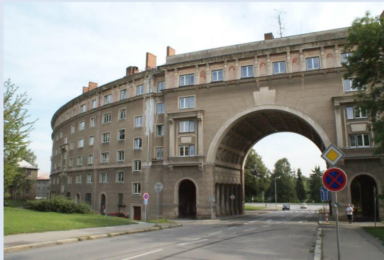
Abb. 24: Bogenhaus in Ostrava-Poruba mit monumentaler Durchfahrt
